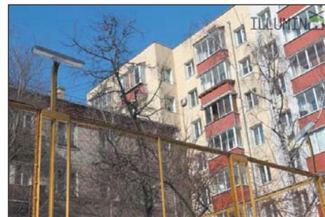
Рис. 6. Крепление уличного светильника непосредственно на ограду
