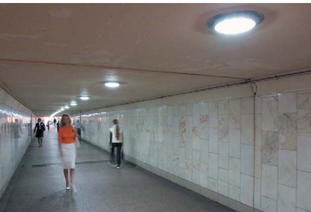
Рис. 1. Светильники ДВУ-25 на основе светодиодов Cree Xlamp в подземном переходе в Москве
