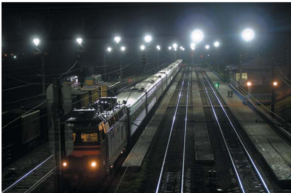
Рис. 6. Освещение пассажирской платформы железнодорожной станции светодиодными светильниками
