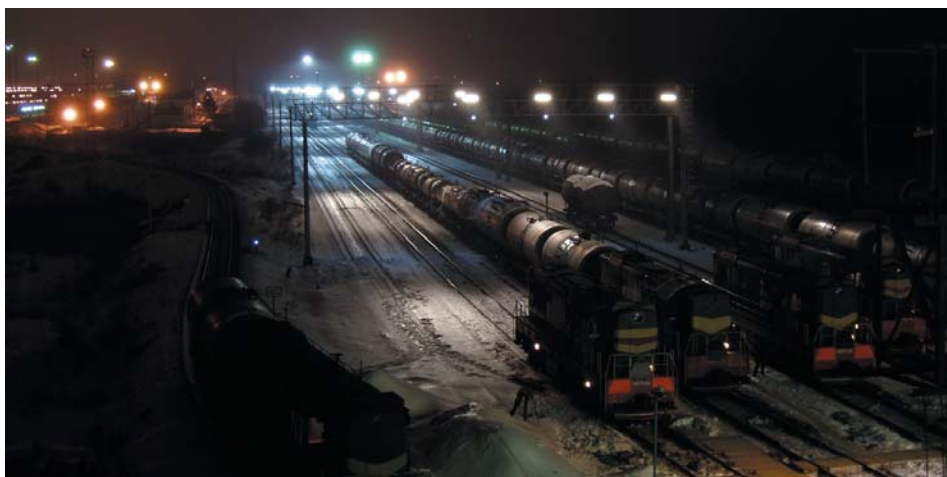
Рис. 7. Освещение сортировочной станции железной дороги светодиодными светильниками
