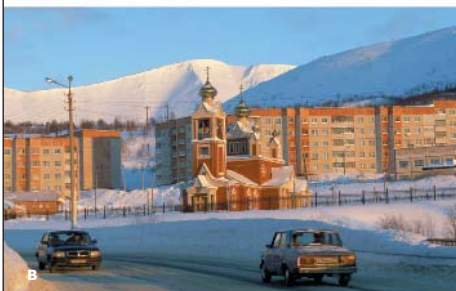
Рис. 1. Церковь в г. Кировске: а) освещение металлогалогенными прожекторами; б) освещение светодиодными прожекторами; в) вид днем
