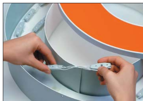
Рис. 2. Монтаж модуля Backlight Protect в объемную букву
