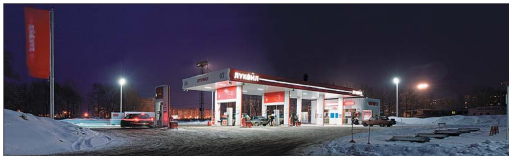
Рис. 2. Пример освещения бензозаправки
