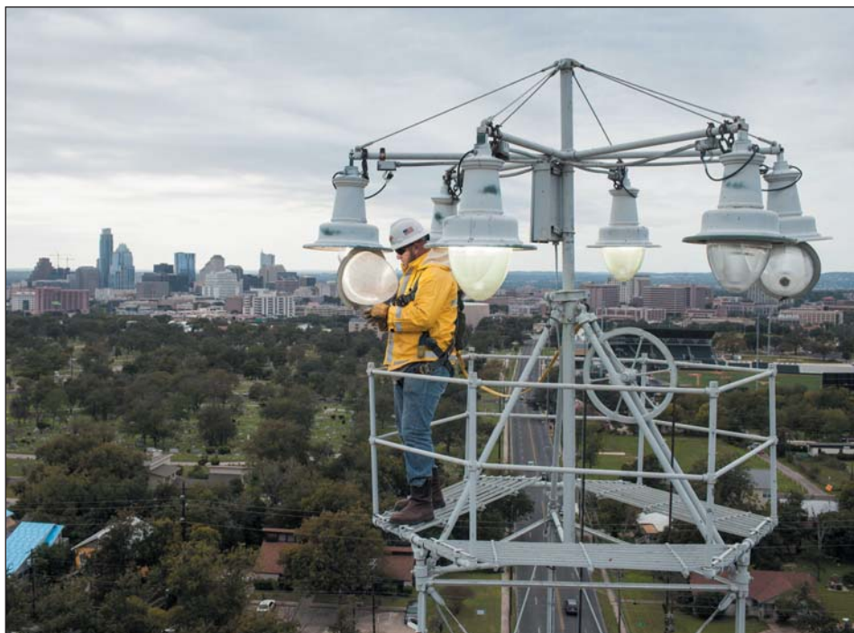
Рис. 4. Обслуживание одной из мачт освещения г. Остин
