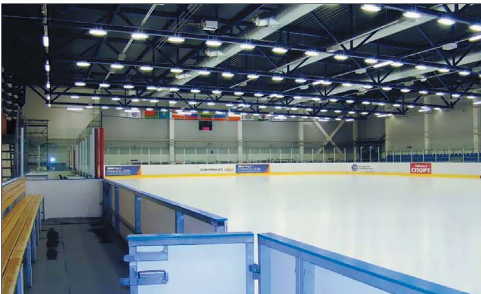
Рис. 4. Светодиодное освещение казанского Ледового дворца спорта (тренировочной базы хоккейного клуба «АК БАРС»). Светильники ТИС-17-2 с индексом цветопередачи более 90
