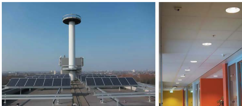
Рис. 9. а) Фотоэлектрические панели; б) светодиодные лампы
