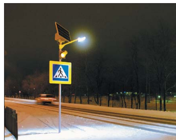
Рис. 2. Комплект освещения пешеходного перехода с датчиком движения и освещенности
