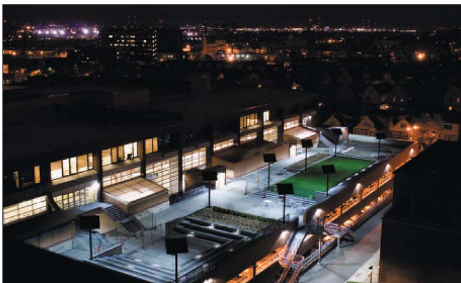
Рис. 3. Университет Нью-Джерси (New Jersey City University) рассчитывает, что установленная на террасе здания Студенческого союза система светодиодного освещения на солнечных батареях будет функционировать даже во время ураганов
