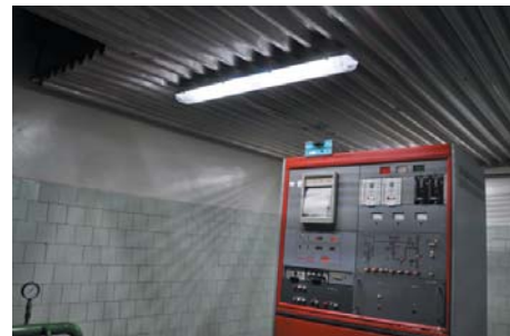
Рис. 1. «Полосатый свет» от светильника Prom-Led с рассеивателем
