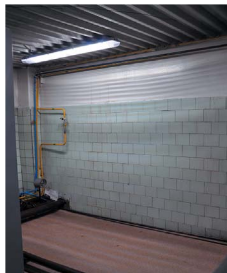
Рис. 2. Неравномерное освещение рабочей поверхности от светильника Prom-Led с рассеивателем
