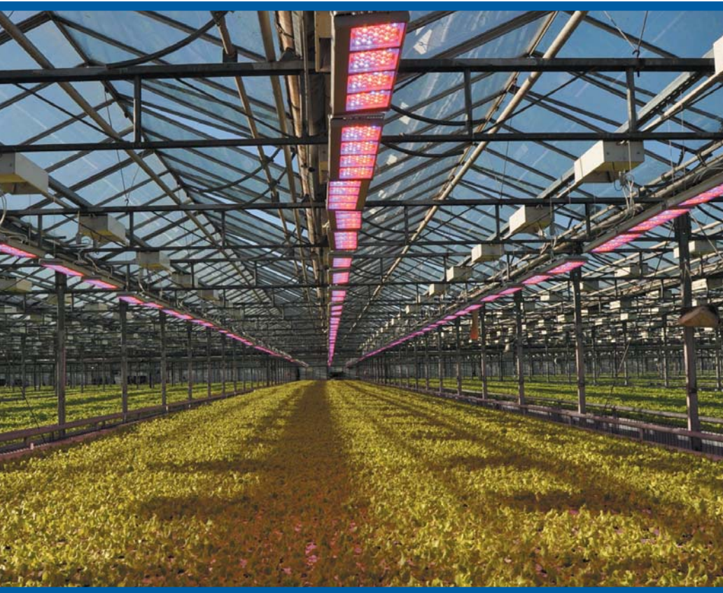
Линия выращивания салата со светодиодными светильниками AtomSvet BIO в теплицах агрокомбината «Московский» (Москва)
