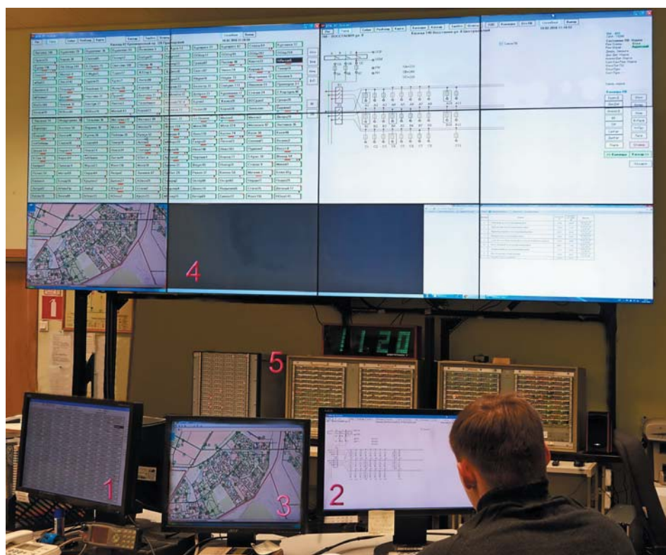
Рис. 6. Аппаратура АСУНО «АВРОРА» на ЦДП ГУП «ЛенСвет» (2016 г.)
