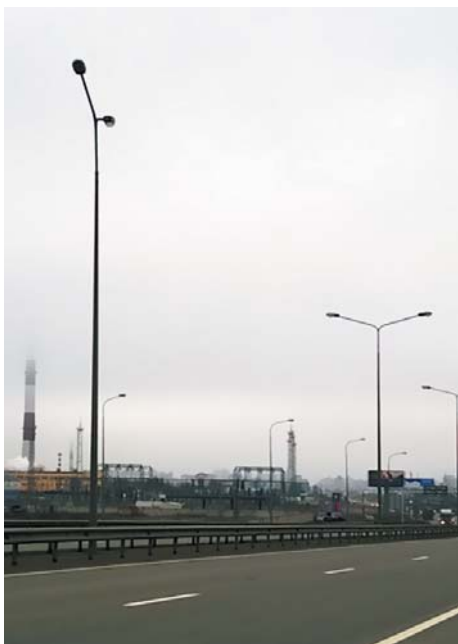
Рис. 7. Разворот светильников после урагана на трассе А-121
