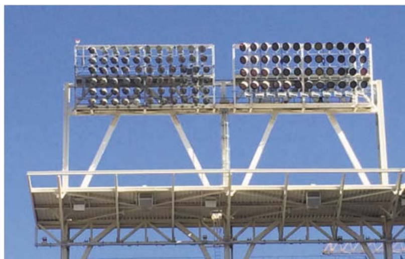
Рис. 5. Слева — предшествующие осветительные стойки на стадионе «Петко-парк» имеют большее количество светильников, установленных в шесть рядов, справа — полупроводниковые светильники, установленные всего в четыре ряда
